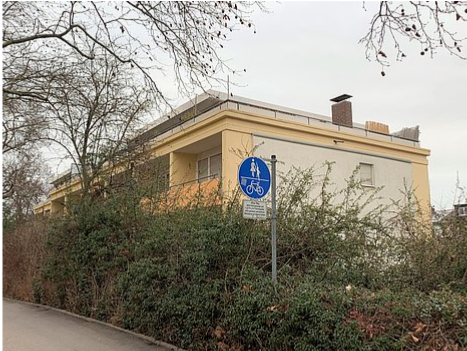
Balkon von außen
